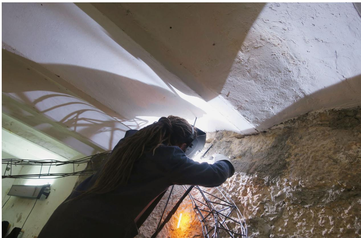
**Ein Gerüst aus Draht bildet die Basis:** Ein Mitarbeiter Wolfgang Zäts fixiert ein Teil des Gerüsts, das später mit hellem Karton umkleidet wird. *zvg*
